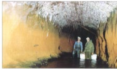
Rothschürbinger Stollen im Bereich der Roten Grube
